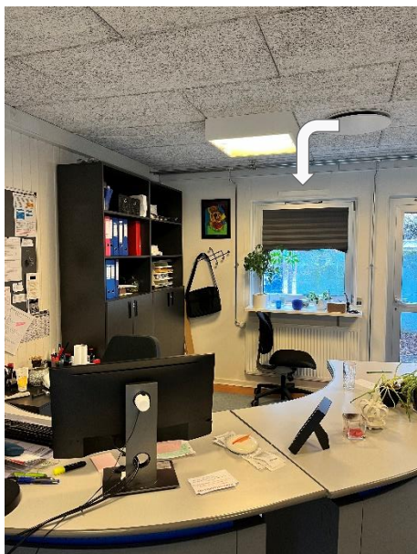
Indblæsningsluft afbøjes af lysarmatur i receptionen
